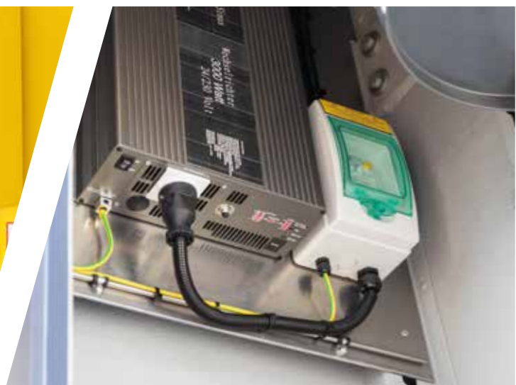
Wechselrichter / Mastervolt-Anlage
