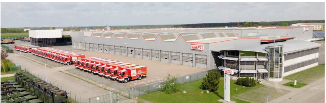
Hauptwerk in Elster, Deutschland Headquarter, Germany
