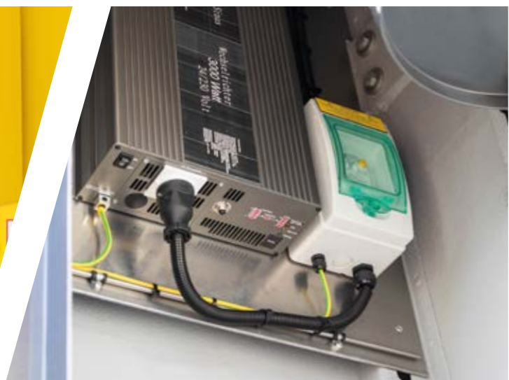
Wechselrichter / Mastervolt-Anlage
